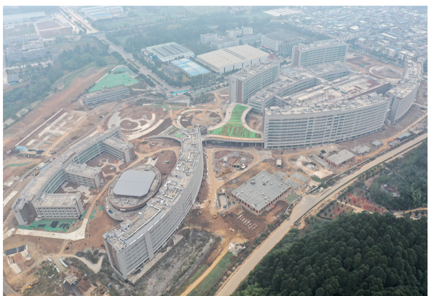
乐山市新区医院建设加紧推进
