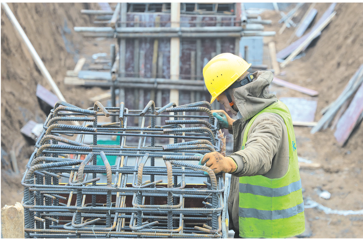
工人加紧施工
