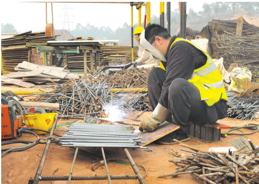
预制菜产业园建设现场
