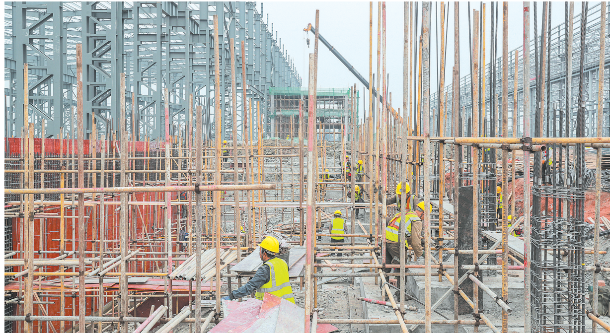
海创尚纬项目施工现场
