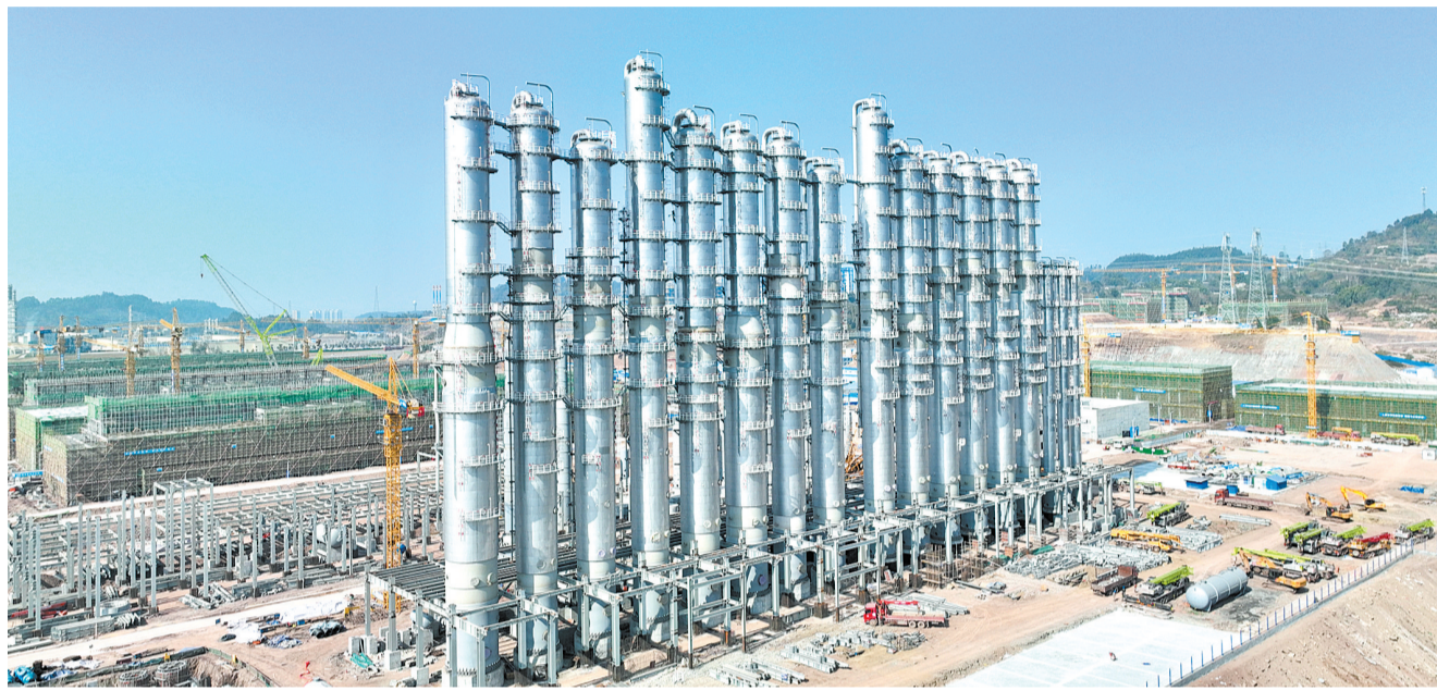
项目建设现场
