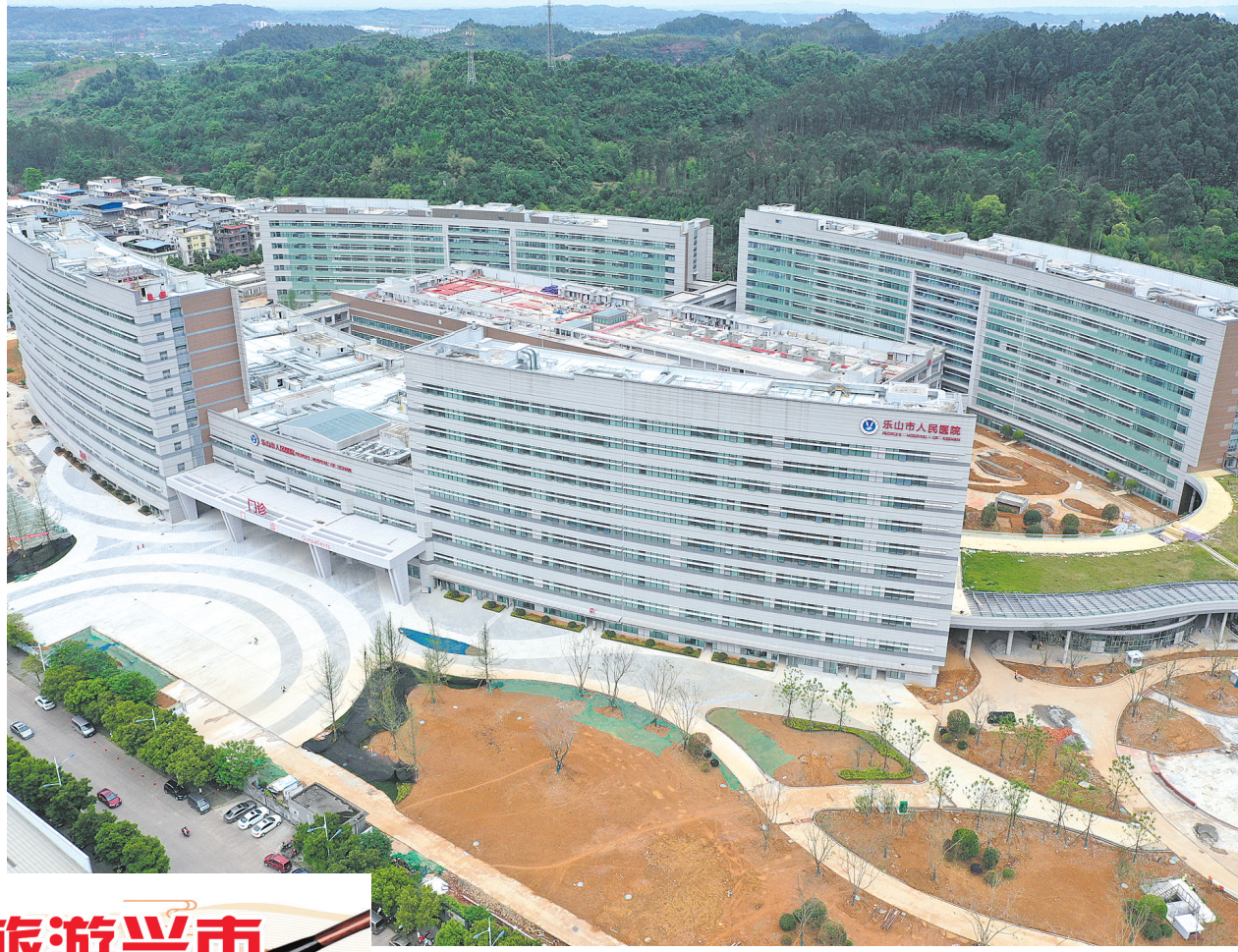
乐山市新区医院主体建筑外部装修已全部完成
