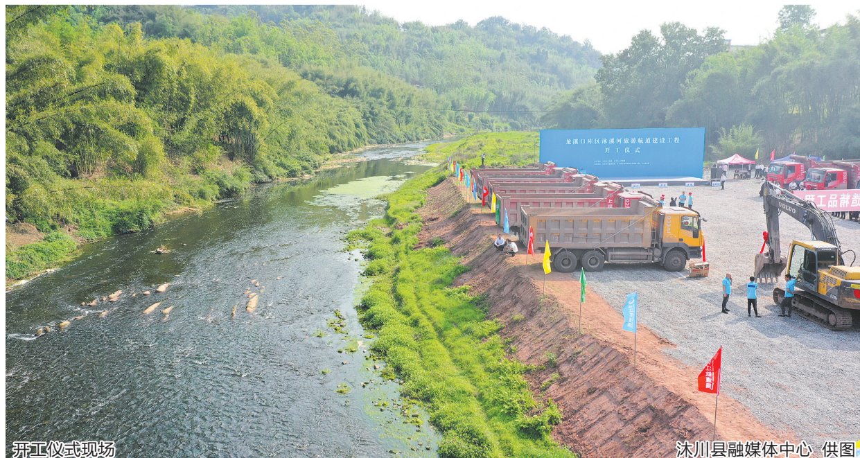
开工仪式现场
