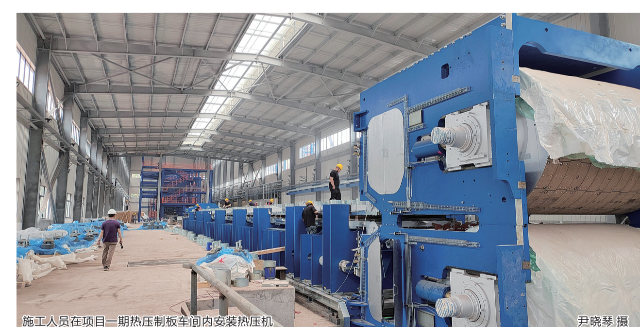
施工人员在项目一期热压制板车间内安装热压机 尹晓琴 摄
