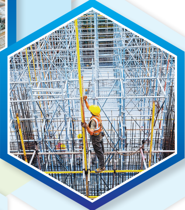
▼四川五通桥经开区工业供水二厂项目建设现场 章慕 摄
