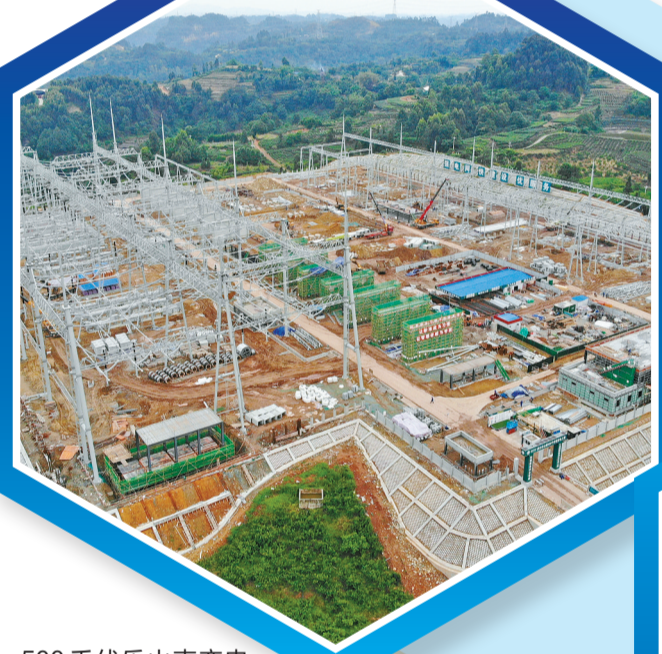
500千伏乐山南变电站正在进行500千伏区域HGIS安装 国网乐山供电公司 供图
