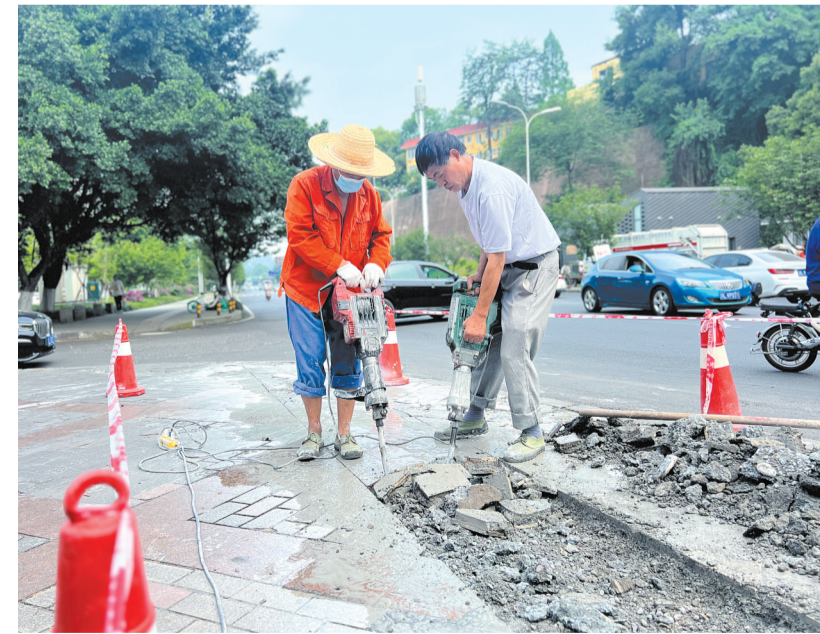
施工工人紧张有序施工
