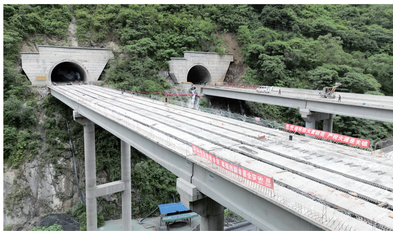
航拍大峡谷隧道进口
