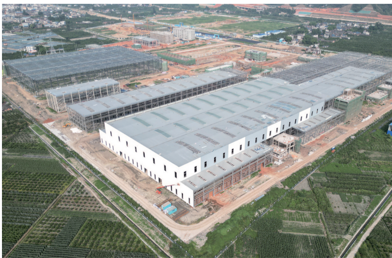
海创尚纬项目建设现场
