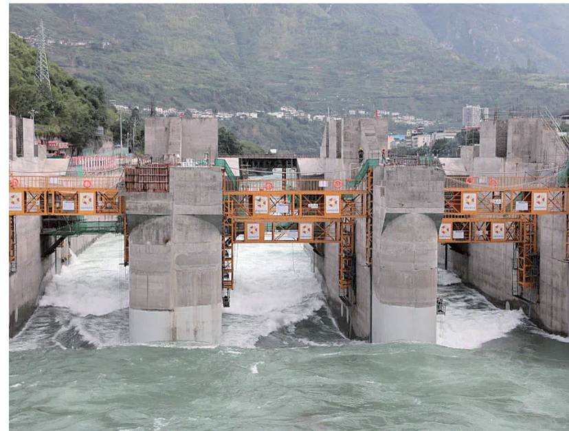
项目建设现场
