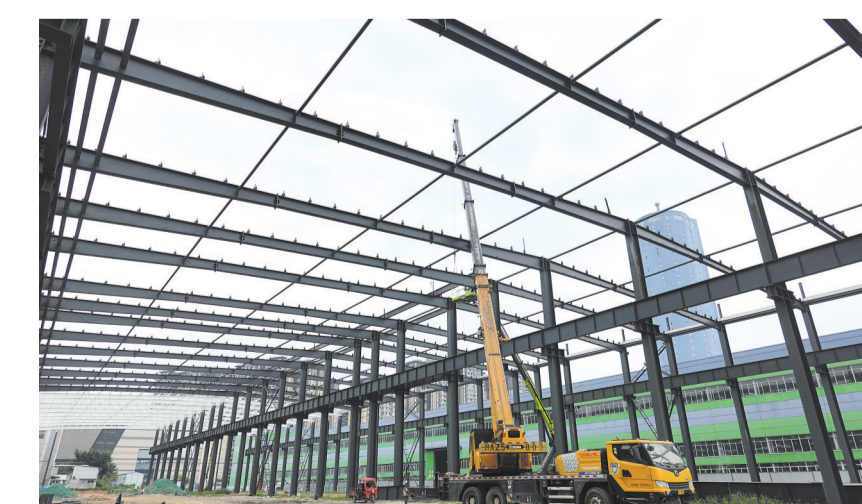
标准化厂房钢结构吊装基本完工
