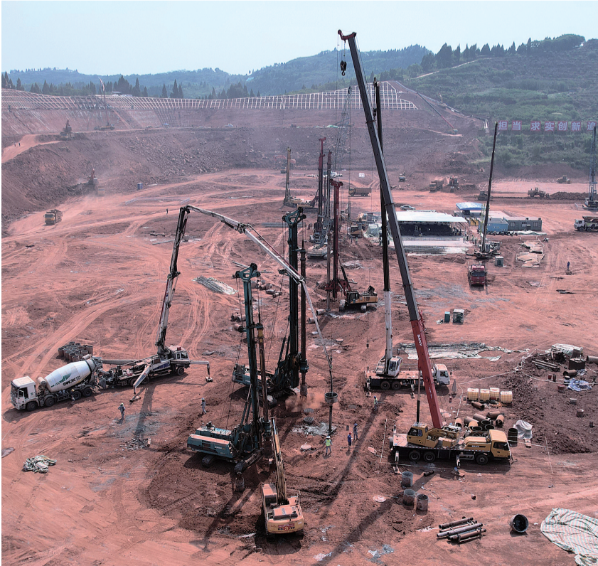
项目建设现场
