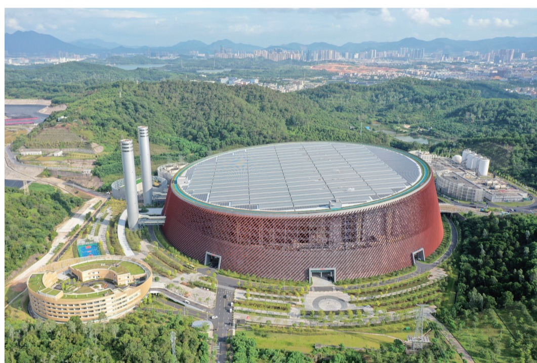
深圳龙岗能源生态园占地面积约54万平方米,日处理生活垃圾5000吨,是目前国内单体建设规模最大的超大型生活垃圾焚烧处理设施,园区内配套建设科普教育基地及餐饮服务,未来将对市民开放(无人机照片,8月8日摄)。
