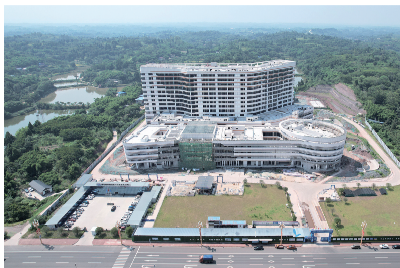
建设项目现场
