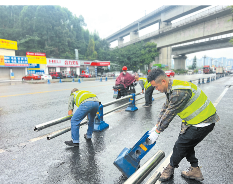
工作人员进行施工前准备工作
