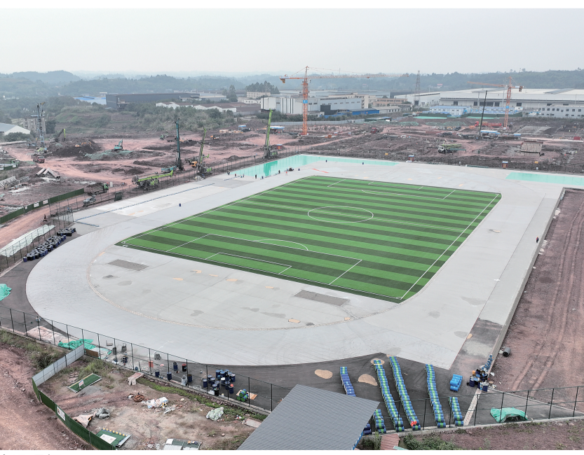
项目建设现场
