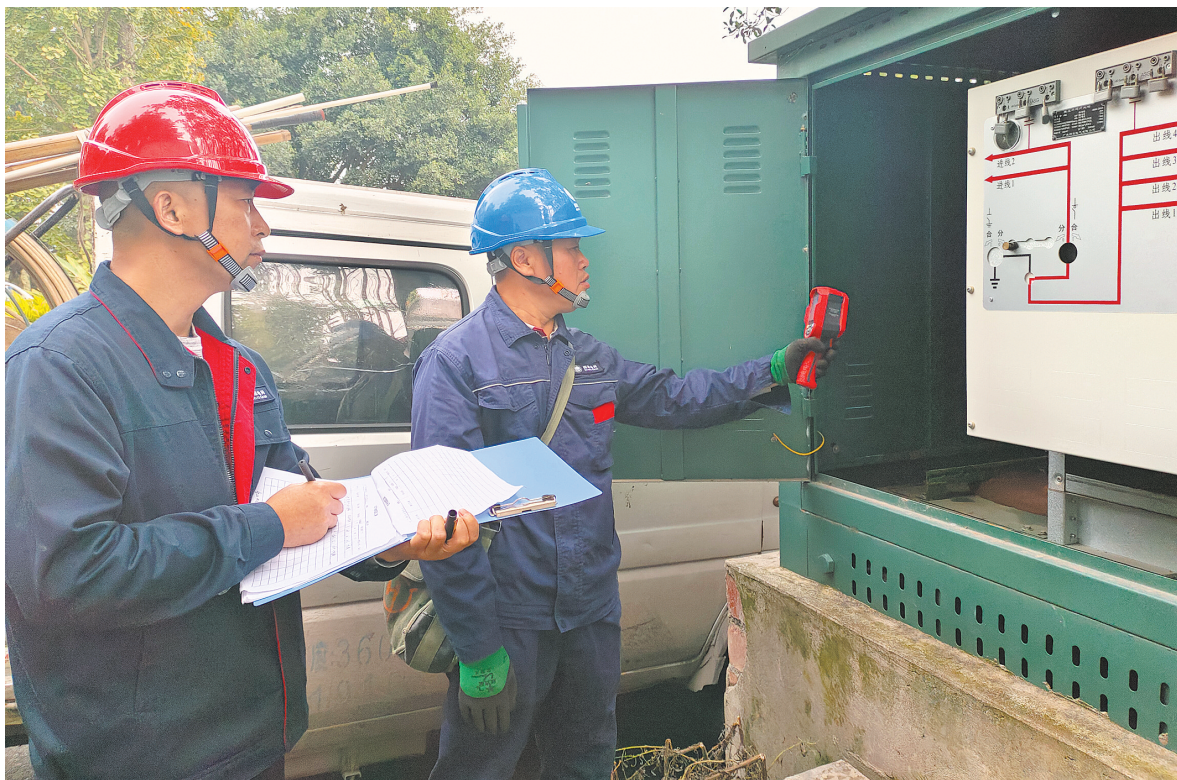
电力人员检查变线路
