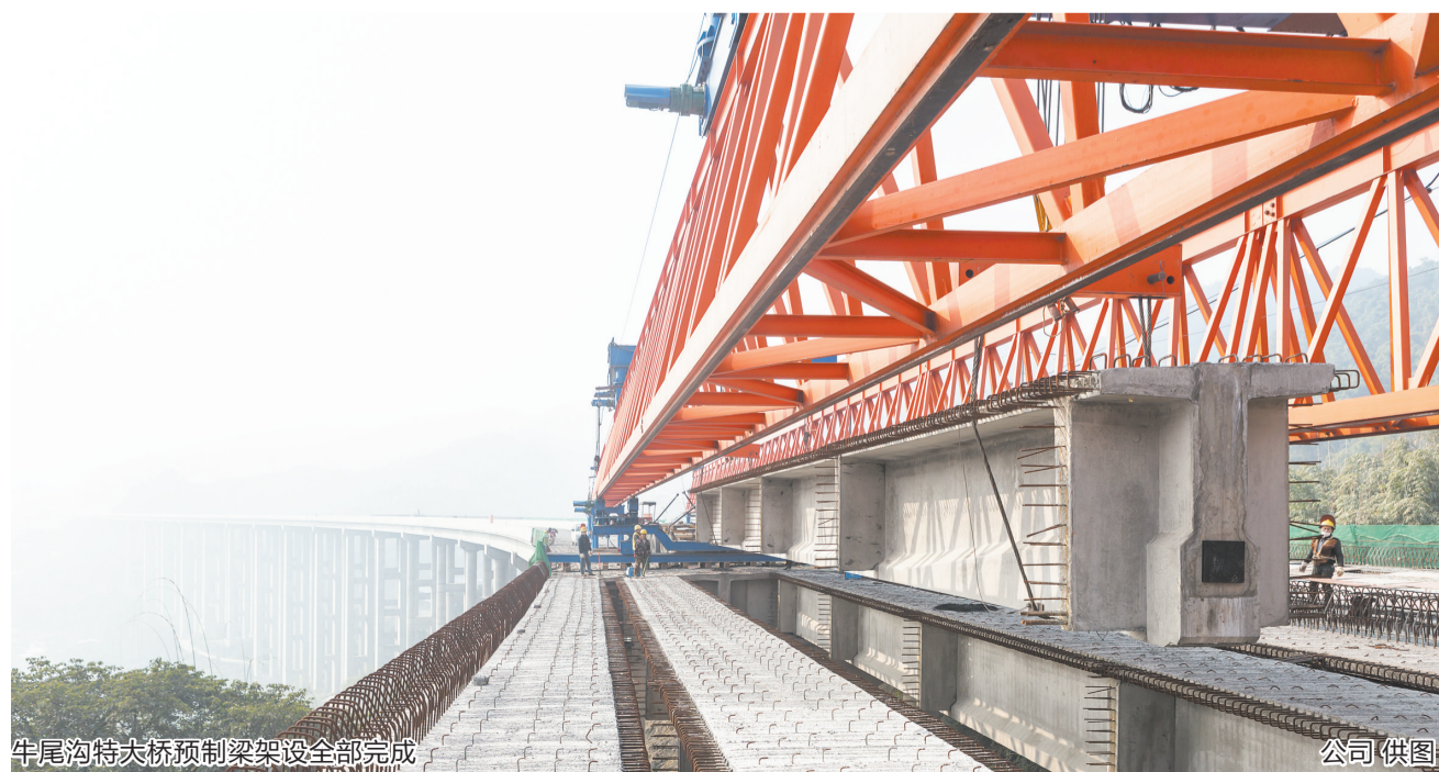
牛尾沟特大桥预制梁架设全部完成
