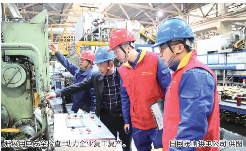
开展用电安全检查，助力企业复工复产。
