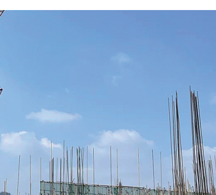
项目施工现场
