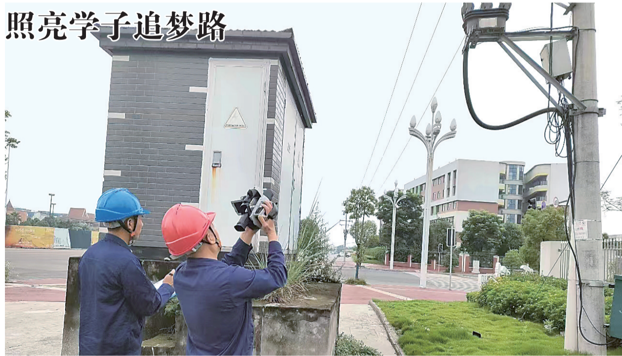
开展电力巡视
