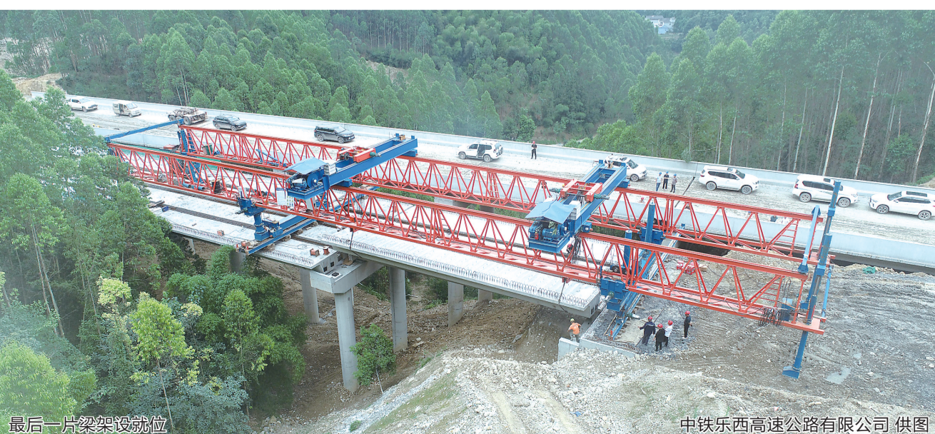
最后一片架梁架设就位
