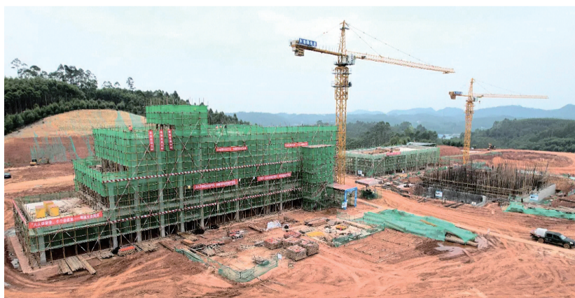
火热的建设现场
