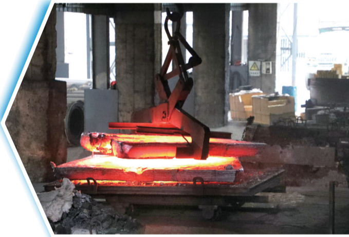
金口河区东岳·鑫河绿色硅基项目建设现场 金口河区融媒体中心 供图
