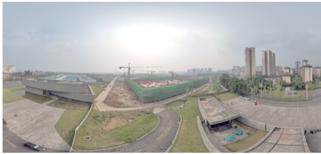
峨眉山市论道·竹叶青茶产业园建设项目现场 峨眉山市融媒体中心 供图
