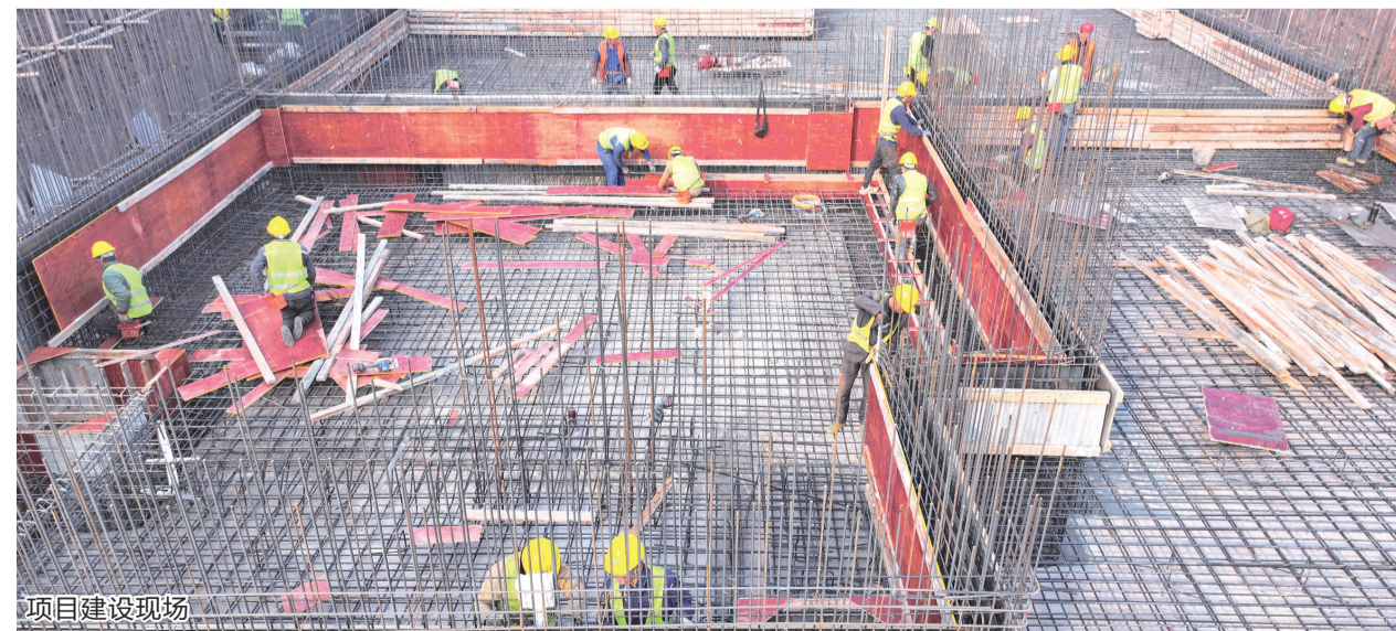
项目建设现场
