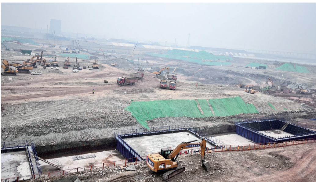
春节期间,岷江老木孔航电枢纽工程建设现场一派繁忙景象。
