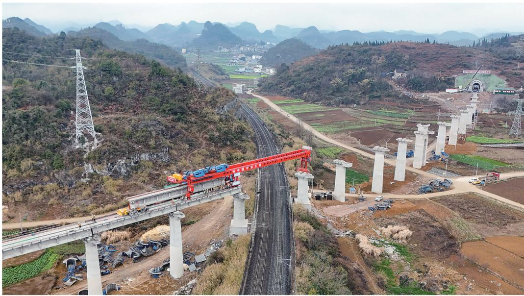
2月13日,在贵州省安顺市境内,作业人员操纵架桥机,将重约135吨的32米T梁成功架设在斗篷山特大桥30-31号桥墩间。新建沪昆铁路至安六铁路客车联络线成功上跨既有沪昆铁路,工程建设取得进展,为项目早日建成通车奠定基础。
