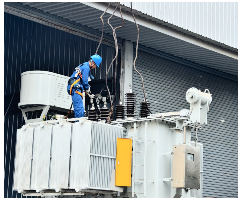
杨公堰变电站增容改造现场
