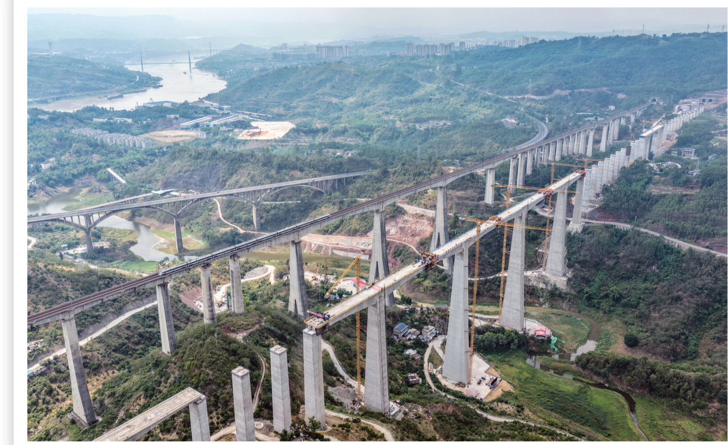
9月1日,由中国铁建大桥局承建的新建重庆至万州高速铁路(渝万高铁)蔡家沟双线特大桥顺利合龙,为全线按期通车奠定坚实基础。
