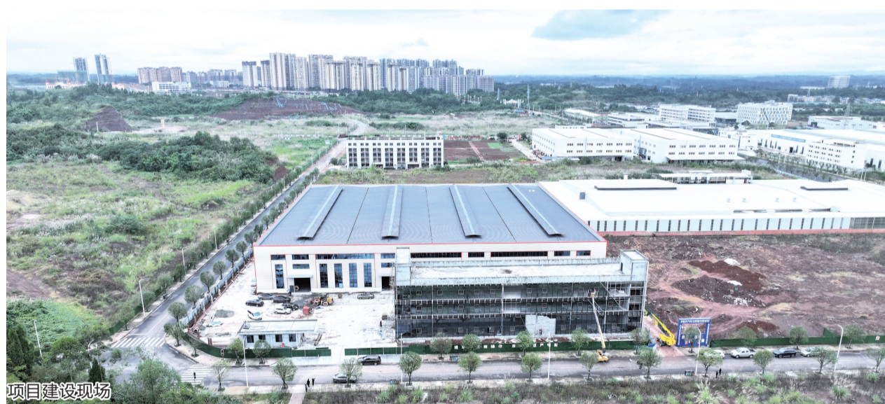
项目建设现场
