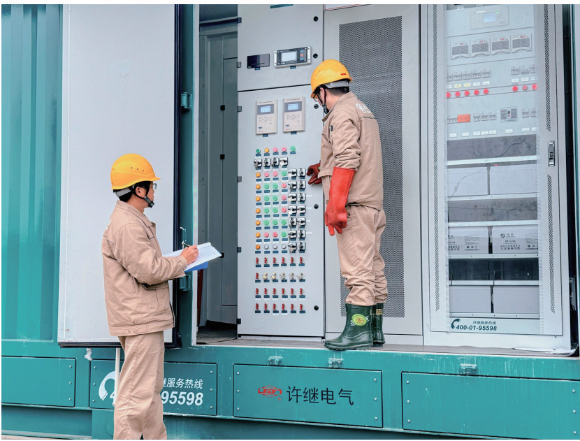
乐山电力犍为公司调度中心员工合上主变开关。
