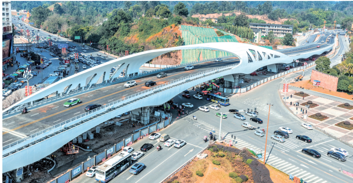
造型现代大气的青衣路交叉口跨线桥。
