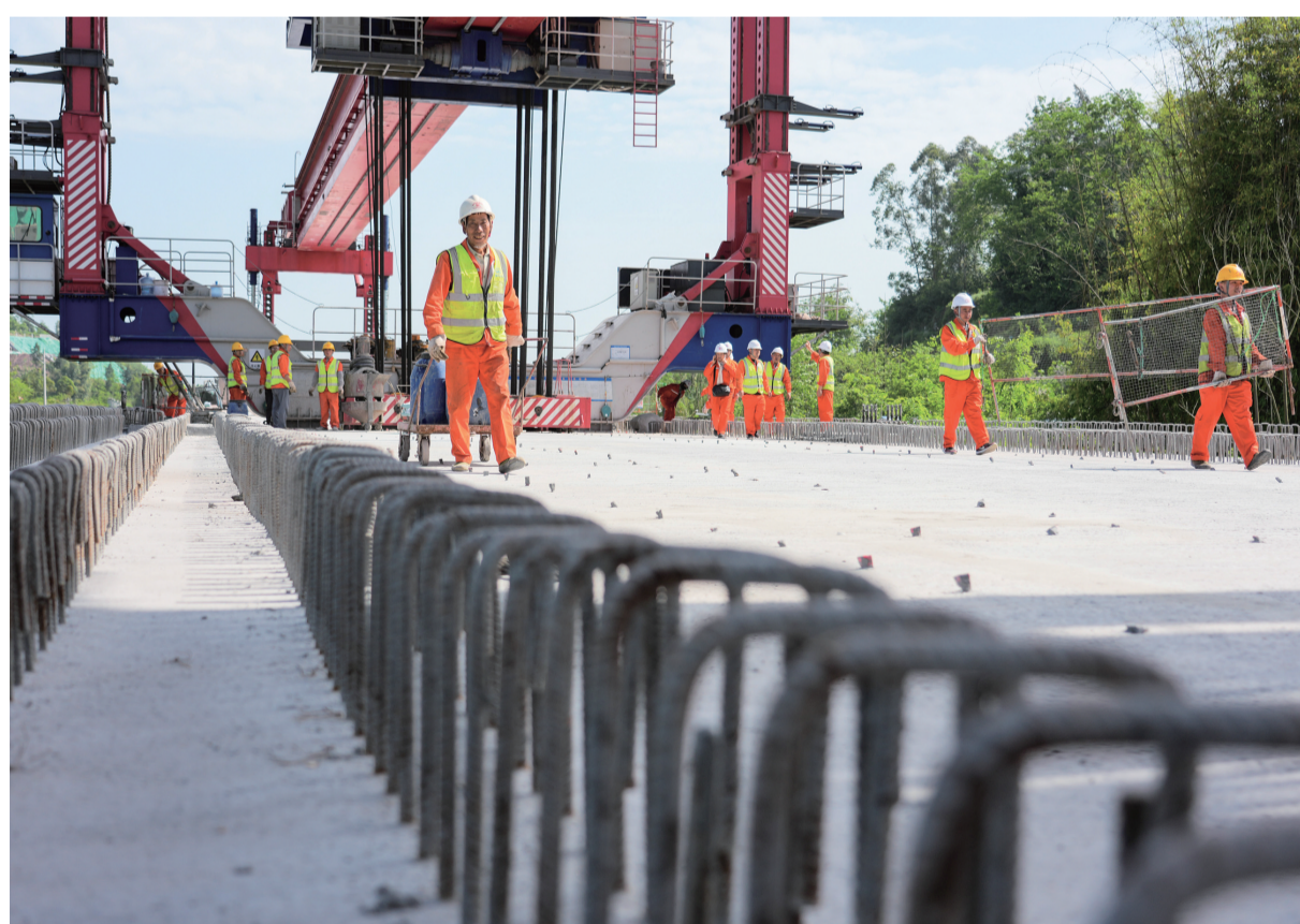
4月17日,由中铁五局承建的西渝高铁双碛楼特大桥最后一孔箱梁完成架设,标志着全长约115公里的西渝高铁达州至广安段共1520孔箱梁架设完工,为下一步无砟轨道施工和铺轨创造了条件。西渝高铁是西安到重庆的高速铁路,全长739公里,设计时速350公里,是我国“八纵八横”高铁网昆通道和包(银)海通道的重要组成部分。
