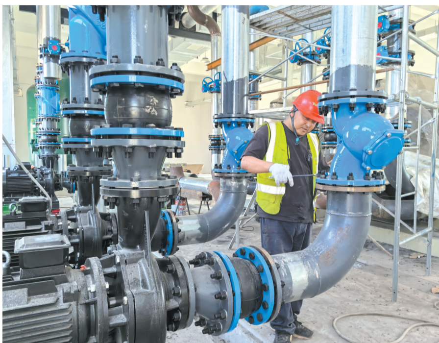
工人进行设备安装。
