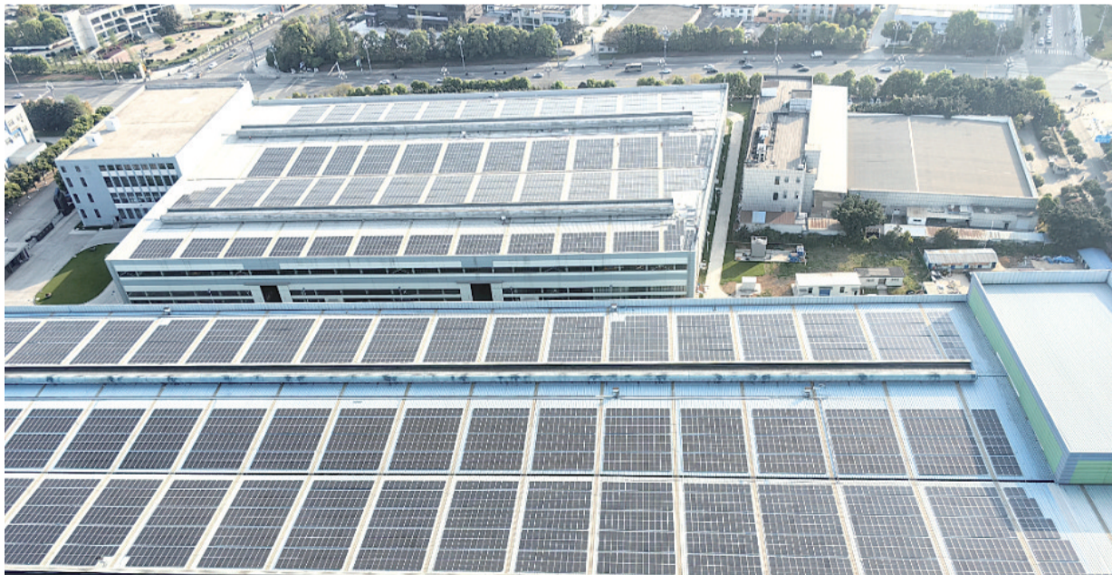
尚纬股份9.08MW分布式光伏发电项目
