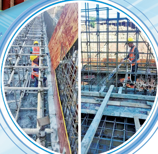
乐山中心城区蟠龙片区的乐山京泰皇冠假日酒店施工现场一片火热。 记者 周柳 摄
