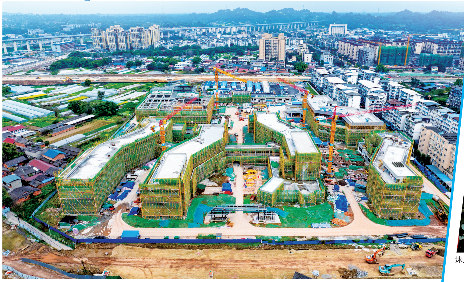
五通桥区通材小学项目加快建设。
