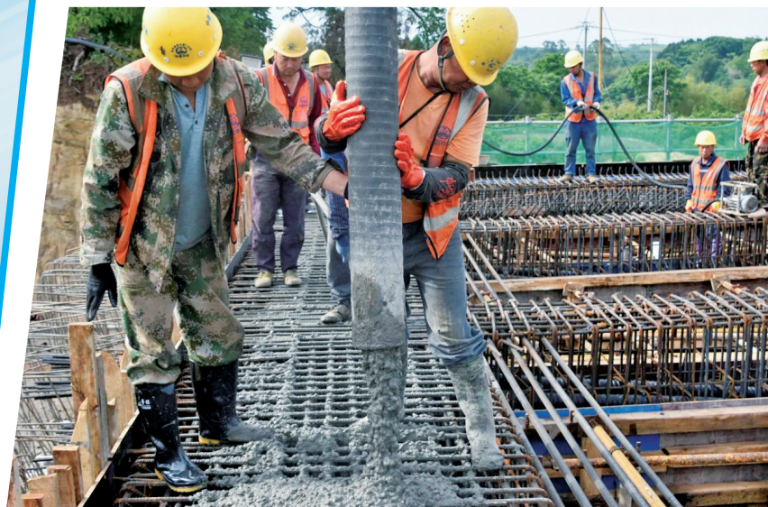
资乐高速公路井研段余家沟大桥顺利完成首联现浇箱梁浇筑。 井研县融媒体中心 供图
