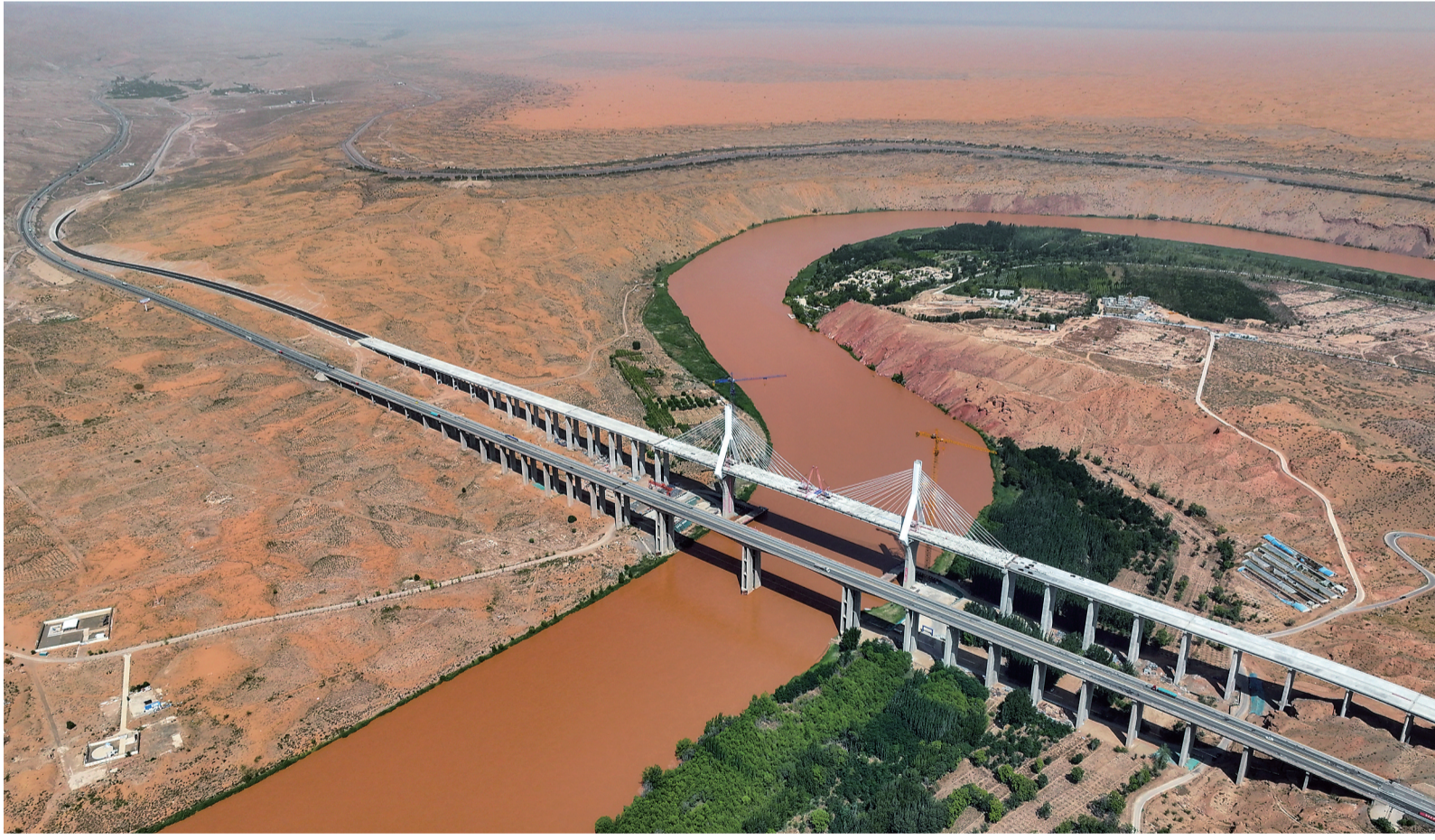
7月3日,位于宁夏中卫市的黑山峡黄河特大桥顺利合龙。该特大桥是国道338线中卫至孟家湾段公路项目控制性工程,顺利合龙为项目实现年内建成通车奠定坚实基础。据了解,黑山峡黄河特大桥全长1539米,主跨240米,是目前黄河宁夏段桥塔最高、倾角最大、施工技术最复杂的公路大桥。项目建成后,将有效缓解既有国道338线的通行压力,完善西北地区公路网络,成为连接兰州、西宁城市群和宁夏沿黄城市带的重要通道。图为7月3日拍摄的黑山峡黄河特大桥(无人机照片)。
