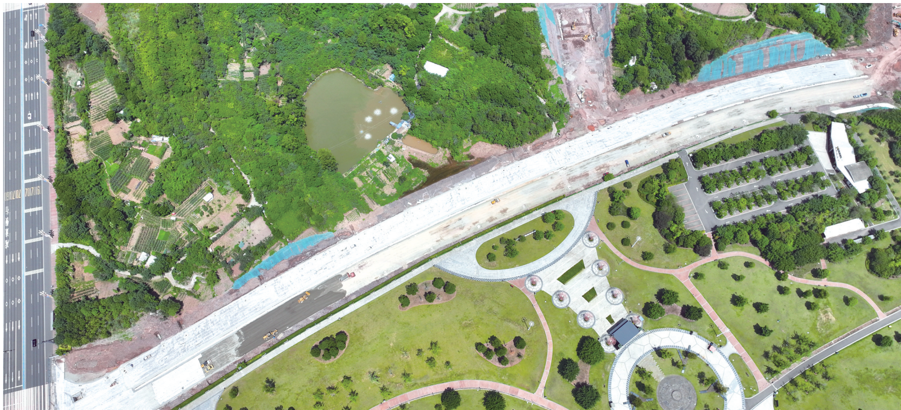
项目建设现场
