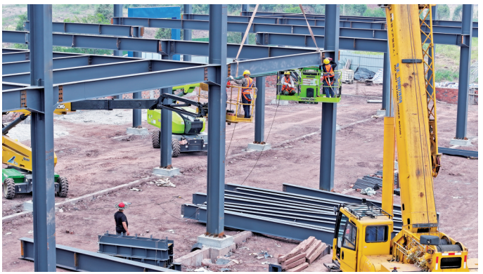
井研县新建智能农业机械生产线项目建设现场 井研县融媒体中心 供图
