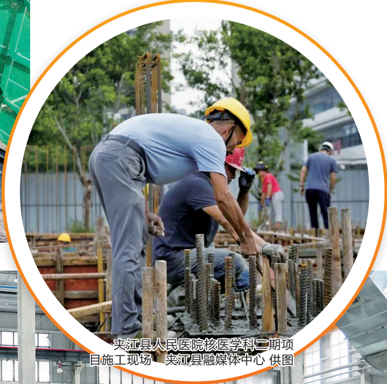
五通桥经开区配套项目建设现场 祝粒珍 摄
