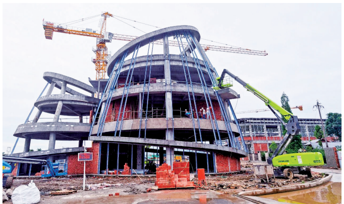
峨眉山市酒水饮料配套产业园基础设施项目建设现场 峨眉山市融媒体中心 供图
