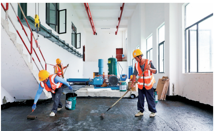
金口河区大渡河左岸流域水资源配置项目(二期)施工现场 熊秋敏 摄
