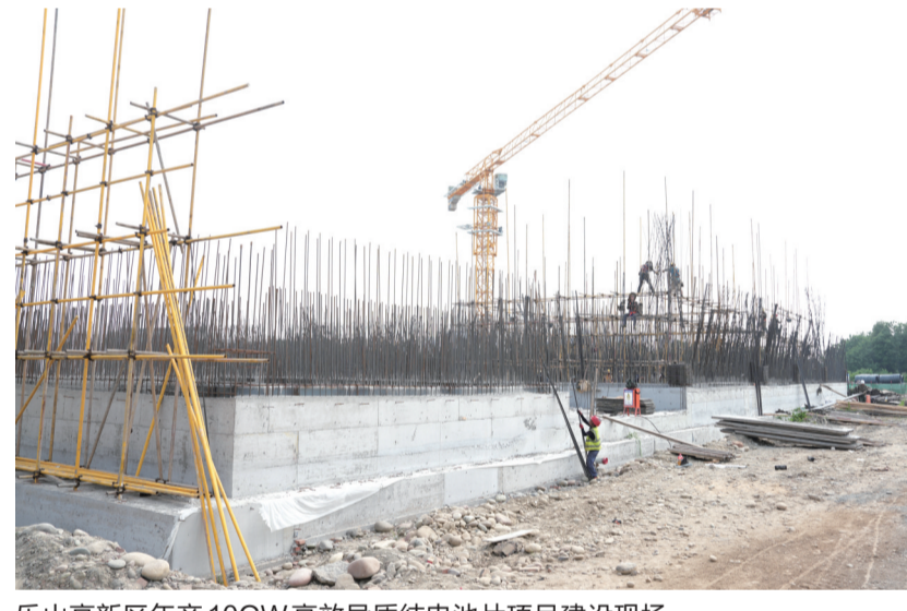
乐山高新区年产10GW高效异质结电池片项目建设现场
