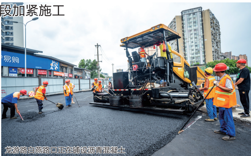
龙游路白燕路口正在铺设沥青混凝土
