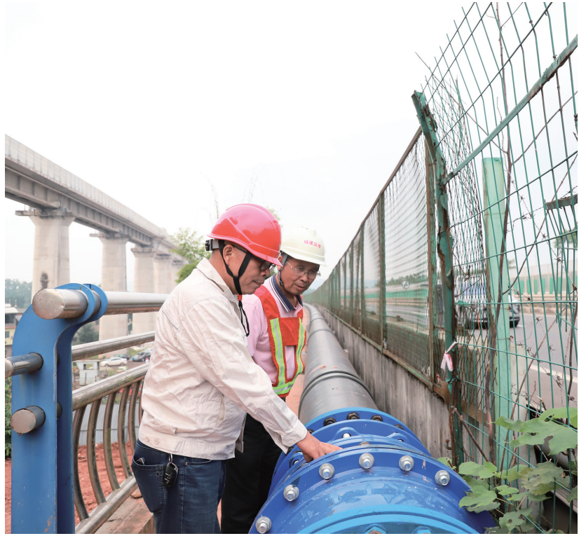
乐自高速桥供水管道项目试压现场
