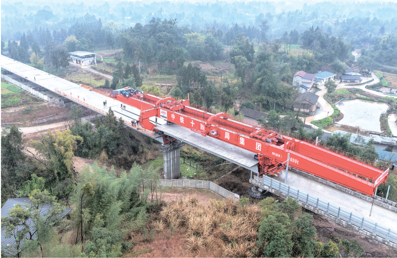
2月9日，随着最后一根箱梁平稳落位，由中铁十四局承建的成渝中线高铁重庆大足段箱梁架设任务收官，为后续无砟轨道铺设、铺轨施工创造条件。成渝中线高铁是我国“八纵八横”高铁网沿江通道的重要组成部分，正线全长292公里，设计时速350公里。图为2月9日拍摄的成渝中线高铁重庆大足段第419根箱梁架设现场(无人机照片)。
