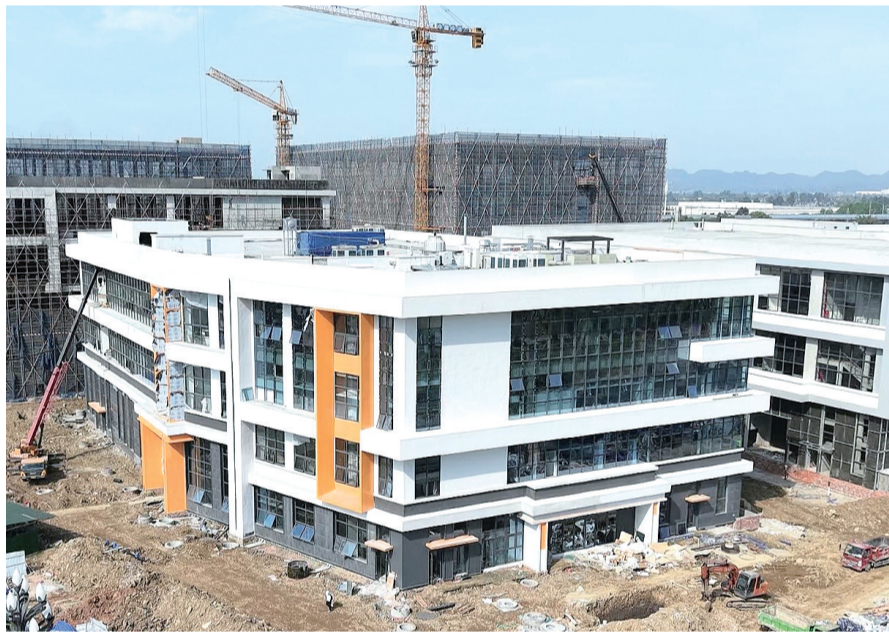
项目(一期)整体建设进度已达90%。
