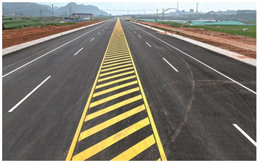
项目已完成的部分路基路面。
