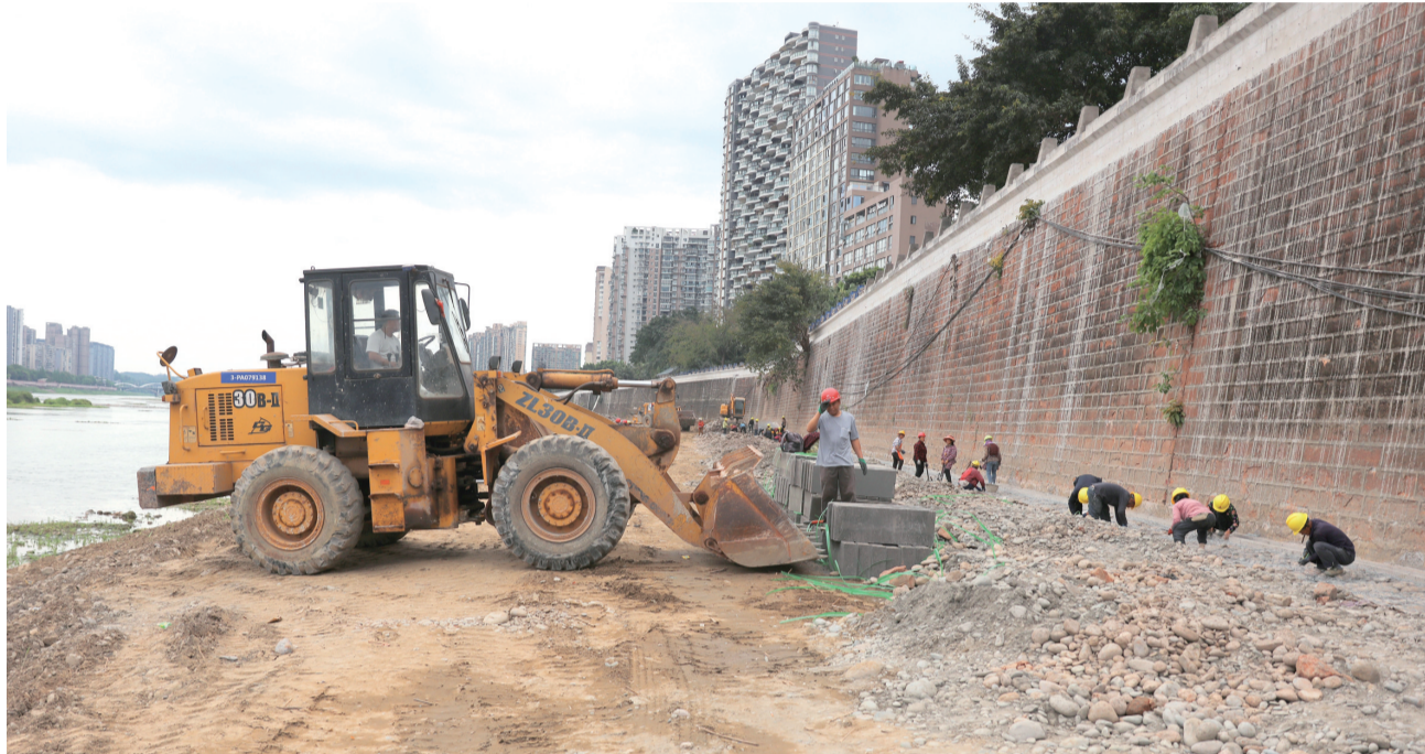
岷江右岸乐山市城区滨江路段堤防整治工程建设现场。
