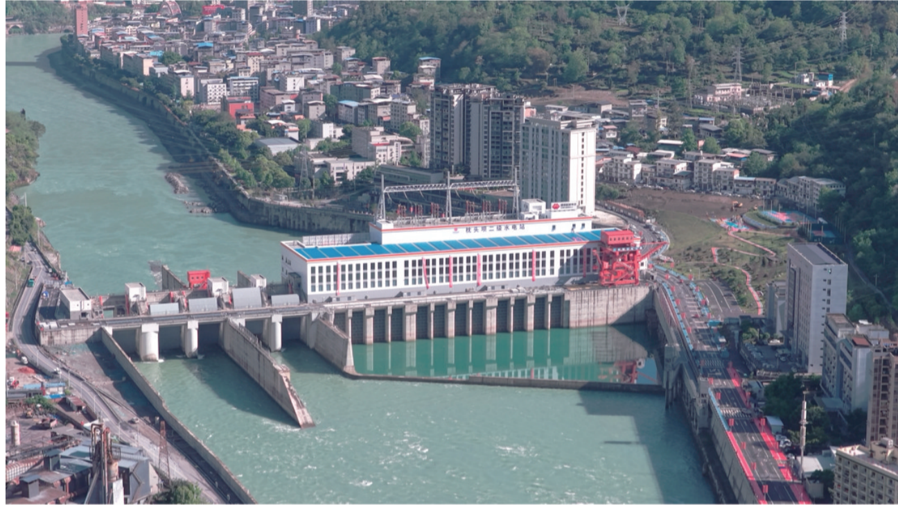
大渡河枕头坝二级水电站。
