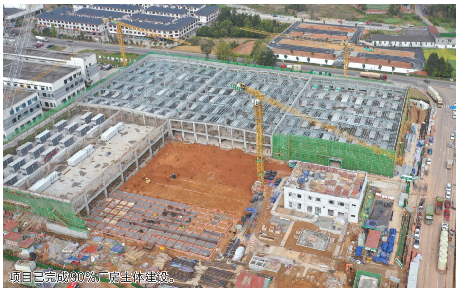
项目已完成90%厂房主体建设。
